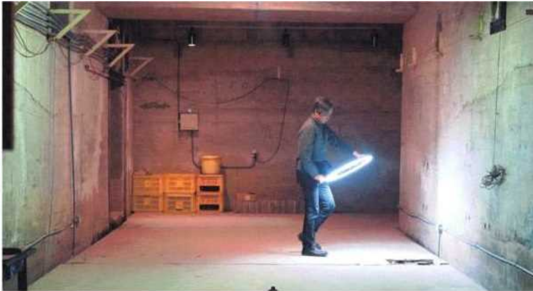
海軍岩川基地の地下発電所跡で調査をする慶応大学の安藤広道教授 〓 曾於市大隅町月野
